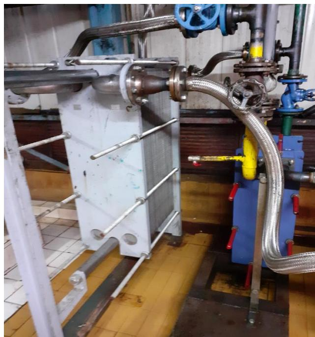
**Slika 2.** Razmenjivači topline ulje-voda paralelno povezani
